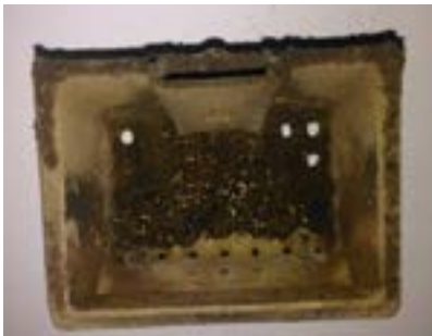
RUSZT KTÓRY WYMAGA CZYSZCZENIA
