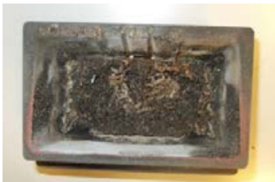
RUSZT KTÓRY WYMAGA CZYSZCZENIA
